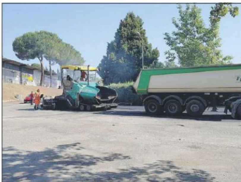
I lavori di riasfaltatura sul piazzale e via della Mezzaluna
